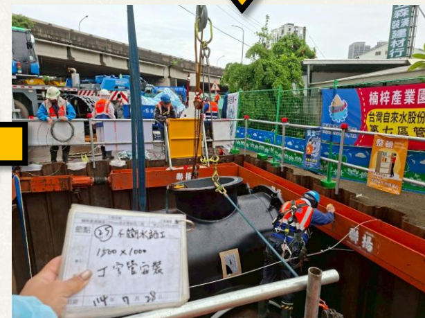
分支管鞍座安裝
