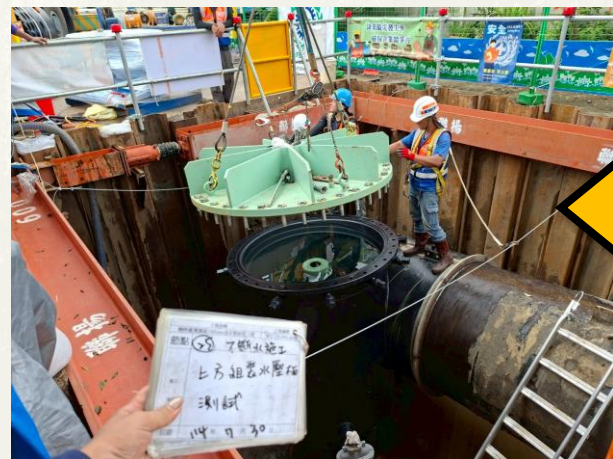
分支管鞍座試水
