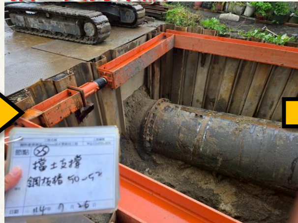
擋土支撐架設
