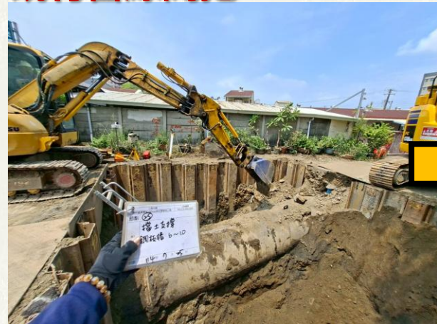
既有管線開挖
