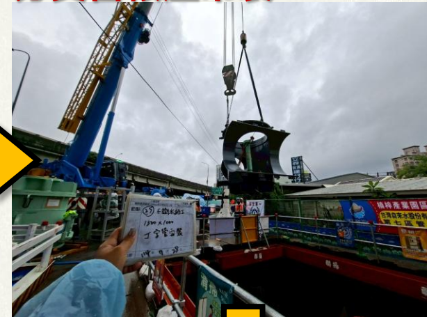
分支管鞍座吊裝
