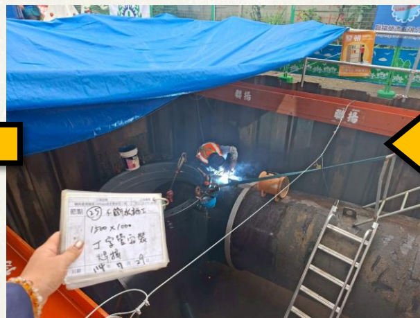
分支管鞍座焊接
